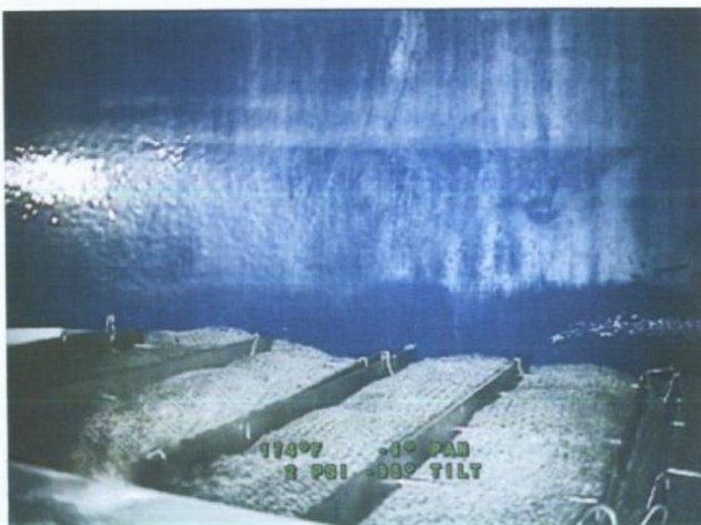
INSPEKTION VON FILTERBÖDEN IN GLAS AUSGEKLEIDETEN BEHÄLTERN
